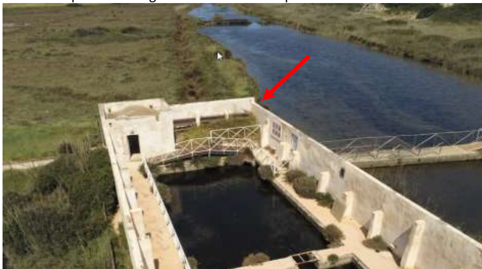
Figura 1: Sito dell'installazione del sistema di monitoraggio coordinate (40.811015, 17.521752)
